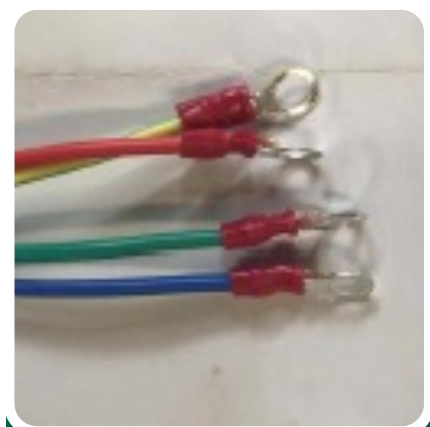
Instrução para conectar o cabo do motor (deixado do lado de fora do Painel de controle): os fios sob tensão são vermelho, azul e verde, o fio terra é amarelo e posicionados no local indicado pela flecha
